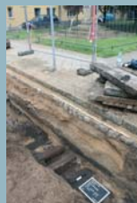
Holzrinne nach der Freilegung
