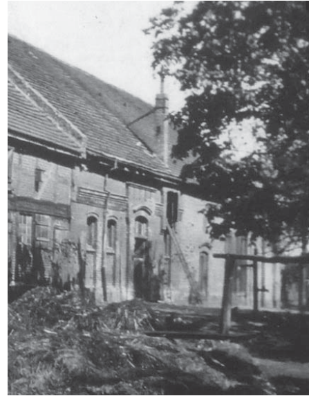
Abb. 25: Stallgebäude im Gutshof, rechts die 2016 gefällte Rosskastanie, um 1930
