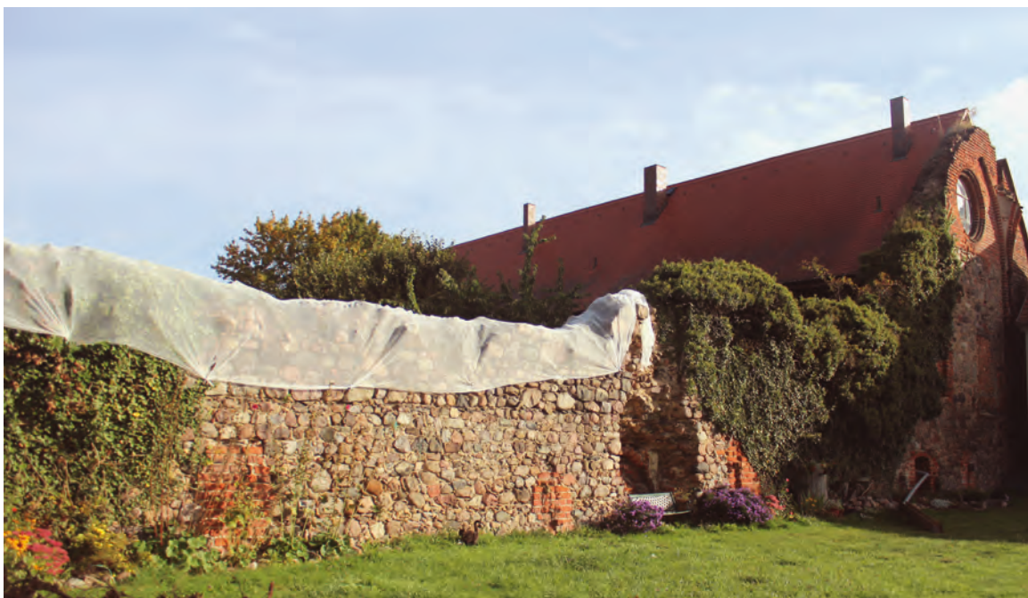
Abb. 2 Die erhaltene Nordwand der Klosterkirche St. Johannis mit angrenzendem Ostflügel während der Sanierungsarbeiten (2013) (Foto: Annett Dittrich).
