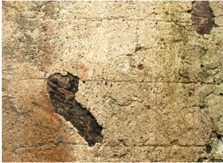
Abb. 9 Weiß verputzte Innenwand mit ehemals farbig gefasstem, horizontalem und vertikalem Fugenstrich aus einem Sakralraum der Kyritzer Klosteranlage (14./15. Jahrhundert) (Foto: Verf.).
